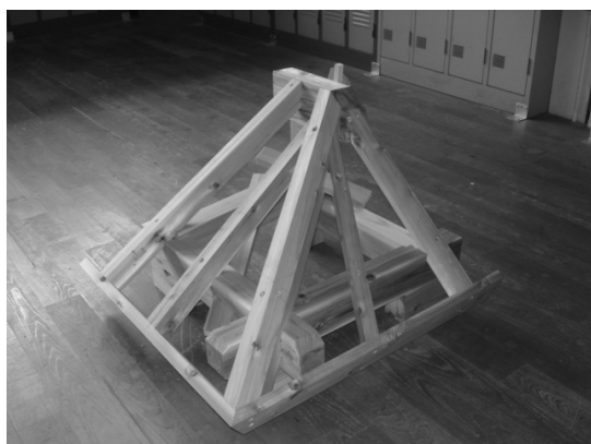
写真1 競技課題「振隅木庇小屋組」
